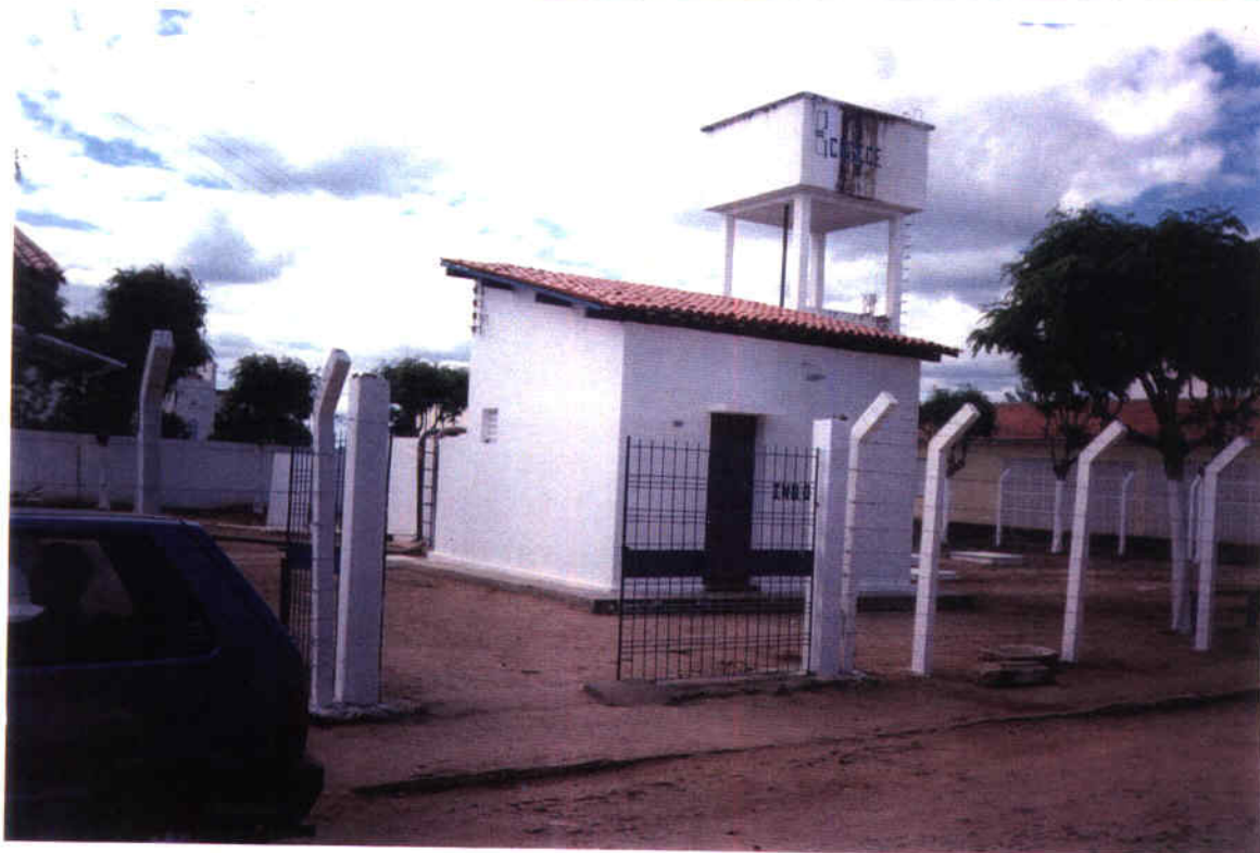
FOTO 4 - Estação de tratamento de água de Paramotí.
