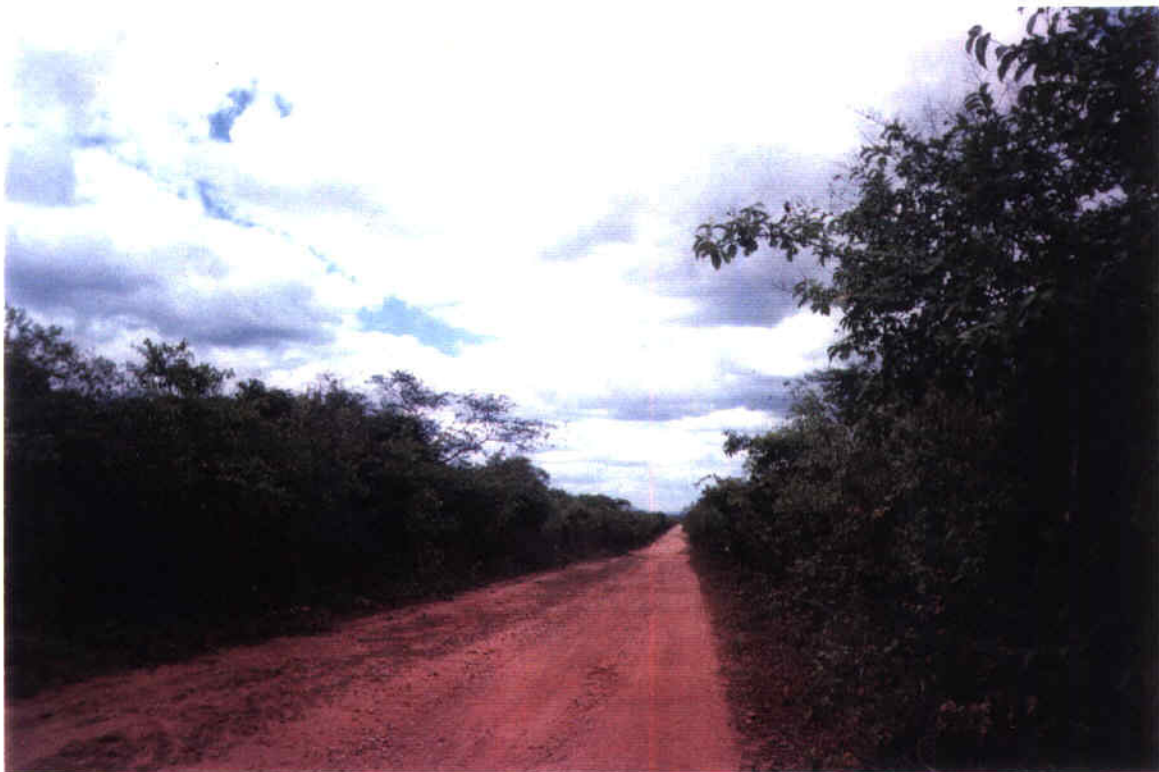
FOTO 2 - Estrada que liga Paramoti a General Sampaio passando pro Água Boa (trecho da alternativa III).
